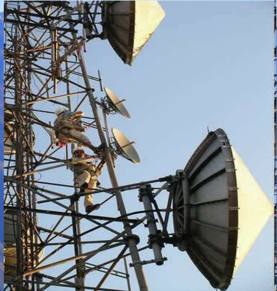
Zomba Peak antenna install Carlo Fonda and Ermanno Pietrosemoli Pietrosemoli
